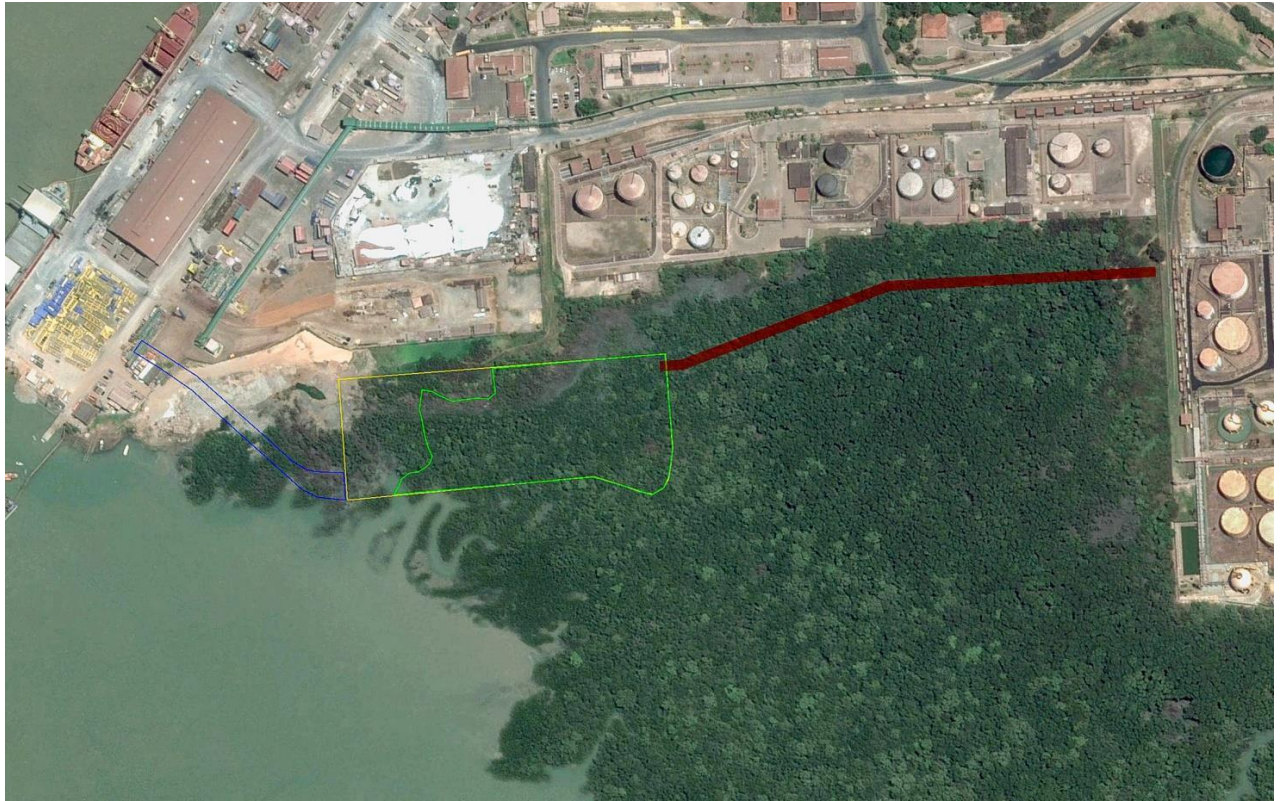
Figura nº 4 - O avanço do aterro progride em 2012...
